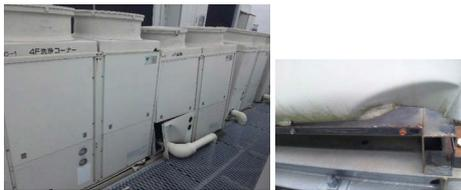
外板の損傷がないか等の目視点検
