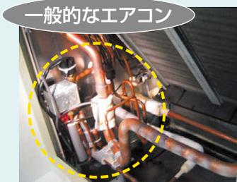
電気部品や配線類が露出しているため、水がかからないように養生が必要でした。(メンテナンスサービスの専門業者に依頼)
